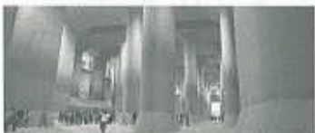
▲首都圏外郭放水路
