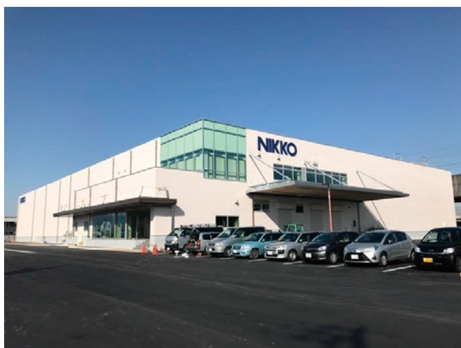
■羽島インター工場
