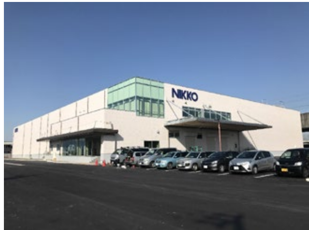
■ 羽島インター工場
